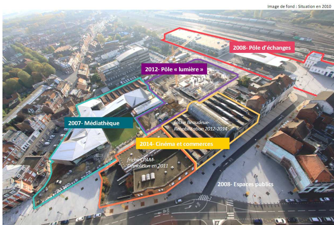
Illustration 8 : Armentières, réaménagement du quartier de la gare – vue aérienne modifiée.
