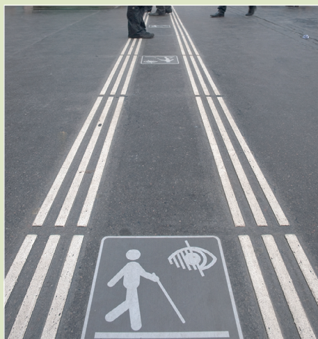
Signalétique accessibilité, bande podotactile © Bernard Suard/MEDDE-MLETR
