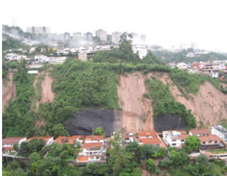
Figure 4. Glissements de terrain dans le secteur de Santa Mónica
