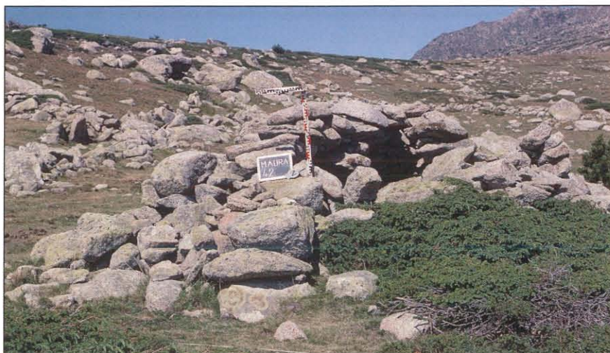
Figure 6 : photographie d'une cabane avec toiture en encorbellement (Serrat de La Padrilla, Montagne d'Enveig, Cerdagne).
