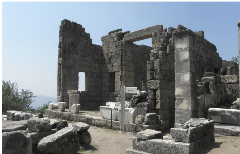
Fig. 2 : Façade nord-est de l'Andrôn A Source : Rivault J., 2015
