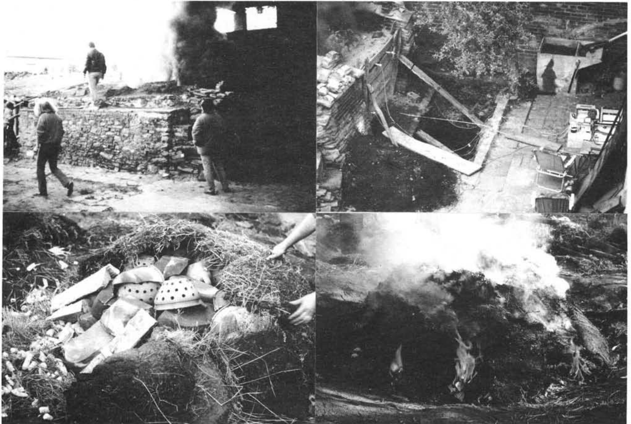
Fig. 9 A - Suivi de cuisson chez Cornella à La Bisbal (Catalogne) et mesure de la température et de la pression, prélèvement des gaz (clichés J.T.).
