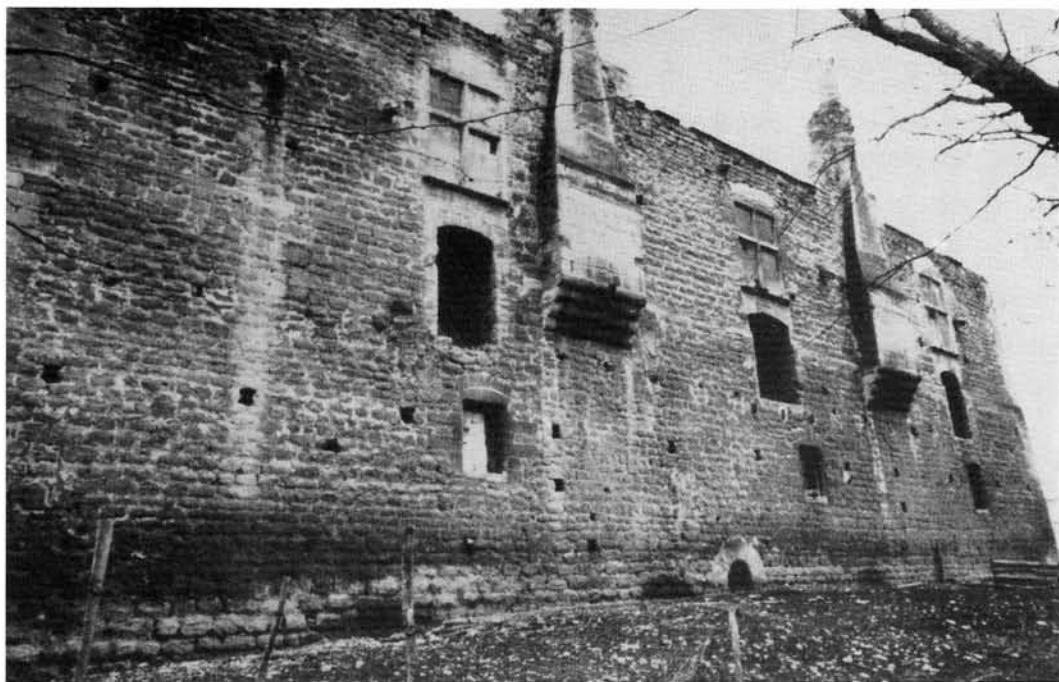
52. Façade occidentale de la bastide de Fargues (cliché H. Aliquot).
