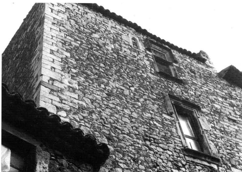
45. Façade ouest de la maison " de pretiosa ".
