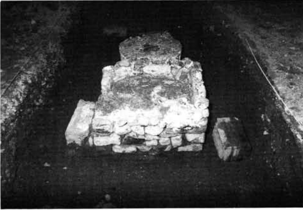
77. Construction de pierre et de plâtre mise au jour dans le niveau de construction de la nef (2ème moitié XIIIe siècle).
