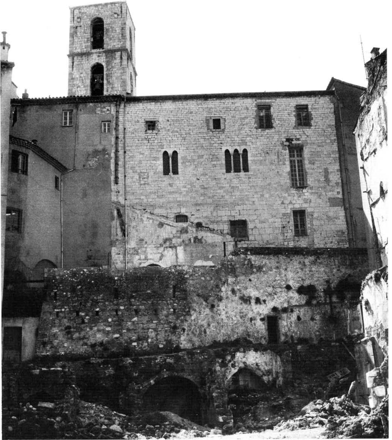
39. Façade nord du palais épiscopal de Grasse; les baies supérieures correspondent à un étage aménagé aux dépens de la grande salle (cliché Roucaute - Inventaire Général).
