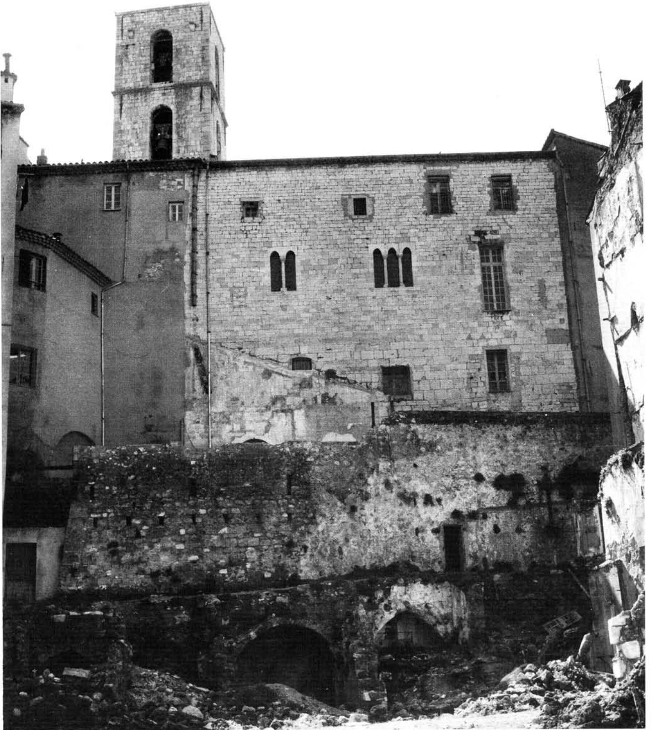
39. Façade nord du palais épiscopal de Grasse; les baies supérieures correspondent à un étage aménagé aux dépens de la grande salle (cliché Roucaute - Inventaire Général).
