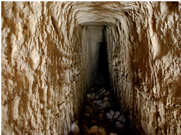
Figure 9. Chantier B. Vue intérieure de la galerie Nord (aqueduc souterrain). Vue vers le nord. ©MafaP
