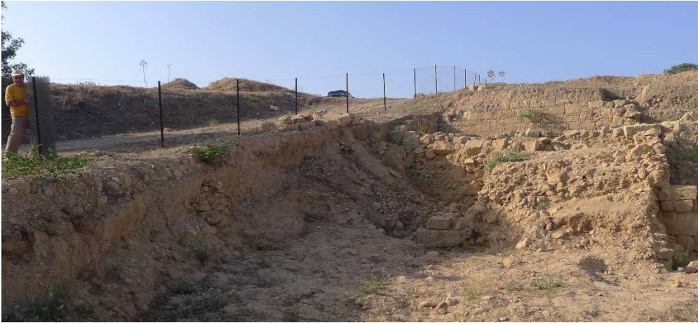
Fig. 14. Le chemin d'accès d'origine avant sa suppression. Vue vers le sud-est.
