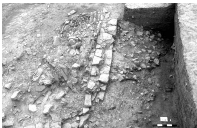
Fig. 27 : Le mur de soutènement MR439 effondré, à gauche, sur le sol d'abandon du second état de l'enclos cultuel. À droite, des remblais postérieurs à l'abandon masquent en grande partie la voie sur berge (cl. M. Gazenbeek).
