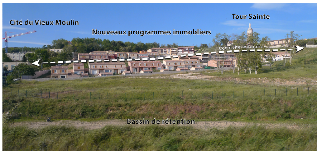
Photographie 2-19 : Les nouvelles résidences fermées de st Joseph dans leur environnement
