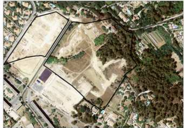
Le Domaine de la Ribassière en construction (2004)
