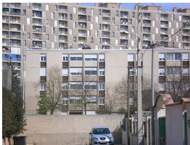
Photographie 3-13 : Mur barrant l'extrémité de la rue face à la cité HLM des Oliviers
