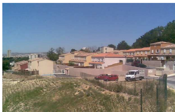
Entrée des résidences (chantier non terminé) - 2008
