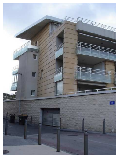
Photographie 1.15 : Résidence Les Îles Bleues, 8 ème (construite en 2005 dans le cadre de la ZAC des vagues)
