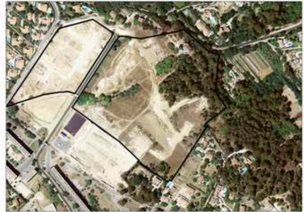
Le Domaine de la Ribassière en construction (2004)
