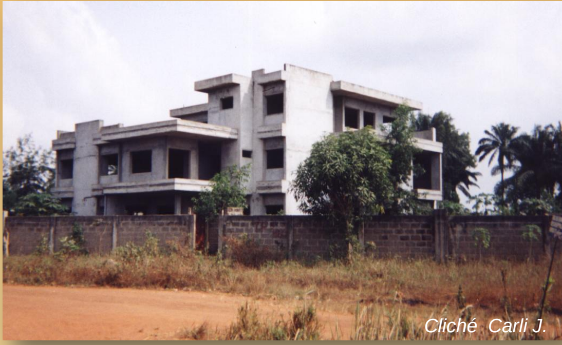
Péri-urbanisation résidentielle des campagnes proches de Porto Novo: maisons à étages qui ponctuent un paysage « semi-rural » (Adjara).
