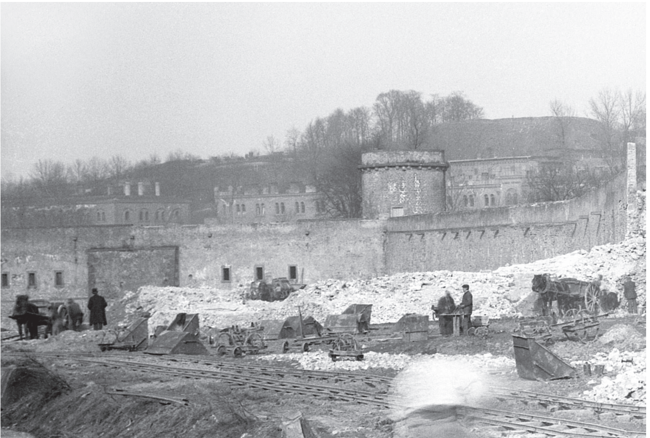
Fig. 13. Vue du secteur de la Grève en cours de remblaiement en 1911 depuis le sud-ouest. La partie supérieure du pont des Grilles de la Basse-Seille est visible (à gauche). Détail (© Musée de La Cour d'Or – Metz Métropole).
