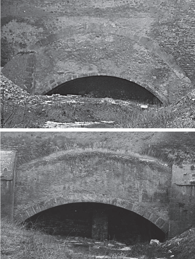
Fig. 12. Vue des arches inférieures orientale (en haut) et occidentale (en bas) depuis le nord-est en 1911. On distingue un appareillage différent. Détails (© Musée de La Cour d'Or – Metz Métropole).
