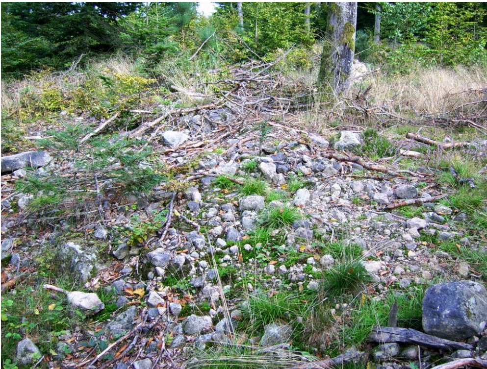
Cliché 14 : Mur ST 3007
