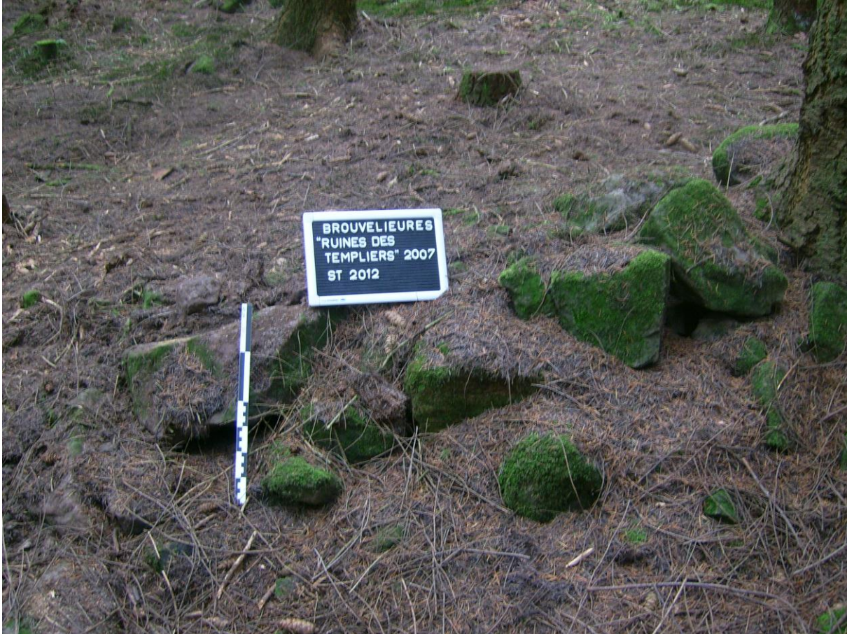
Cliché 6 : Mur ST 2012.
