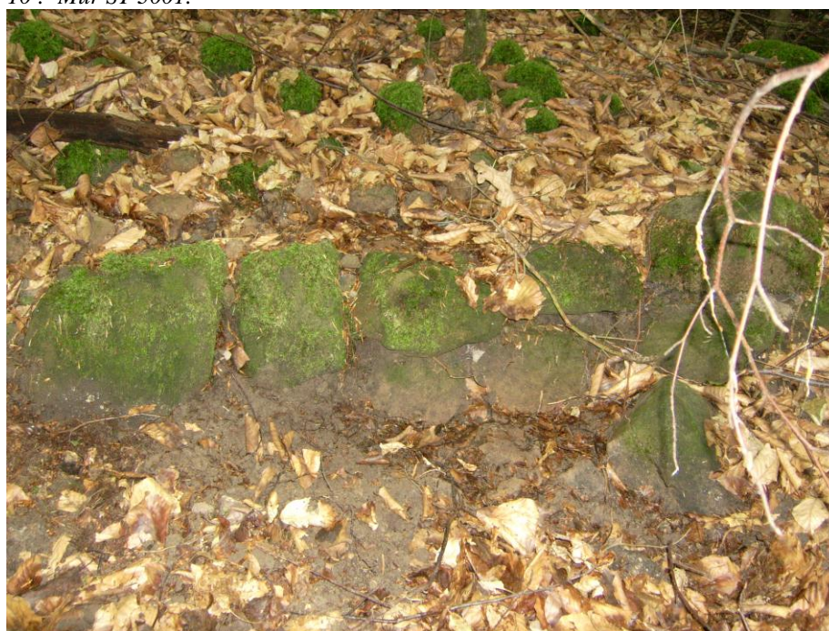
Cliché 11 : Détail du mur ST 3001.
