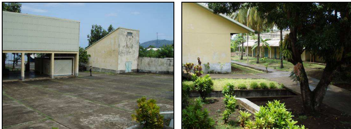
Photos 5 & 6 : la place centrale de l'école et un aperçu des bâtiments administratifs
