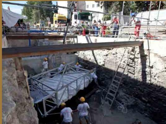
Brod Pula 1 je izvađen na način da je brod poduhvaćen metalnom konstrukcijom koja je omogućila njegovo cjelovito podizanje te transport u posebno izgrađen desalinizacijski bazen unutar kruga brodogradilišta Uljanik u Puli.
