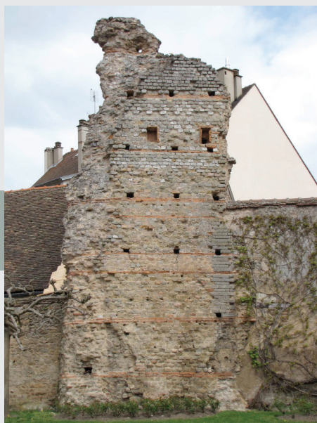
Fig. 1 Photo de la façade Sud du pan de mur (cl. L. Massot).
