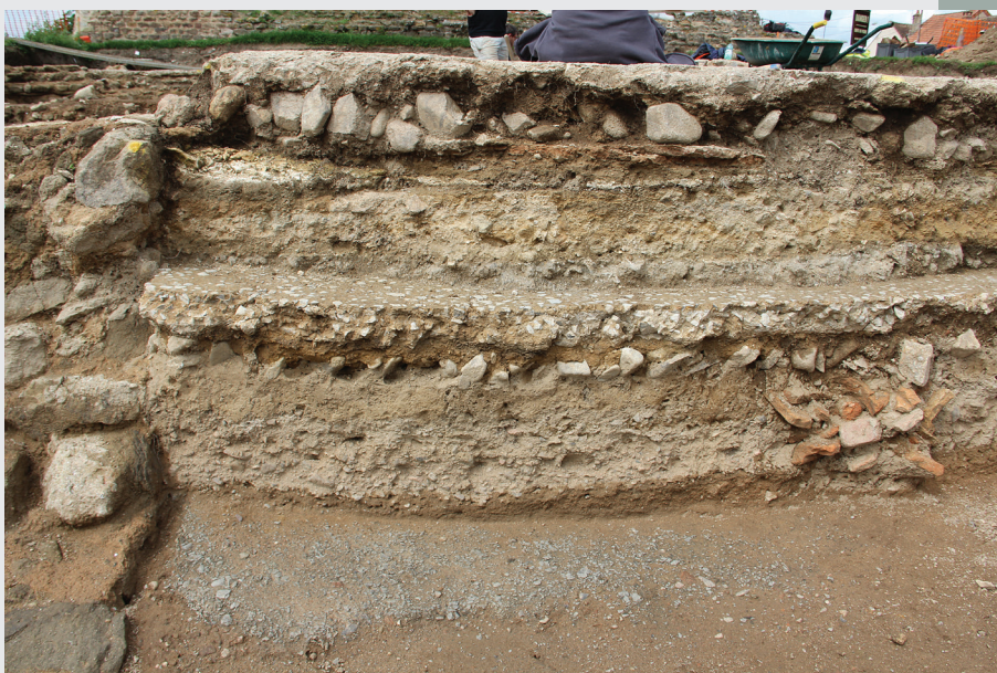
Fig. 6 Vue depuis l'est d'une partie d'une coupe transversale. On distingue nettement les bétons de sol et remblais de construction respectifs du premier péribole (état antique 2) et du vestibule (état antique 3), ainsi que le sol en cailloutis gris-bleu (état antique 1), à la base de la séquence (cl. M. Joly)
