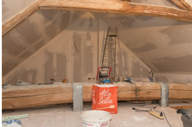
L'isolation des combles et la pompe à chaleur vont permettre à la famille de réduire sa facture de chauffage. C'est Jean-Baptiste qui a posé la laine de verre « en 3 passes », comme le voisin lui a montré au préalable.
