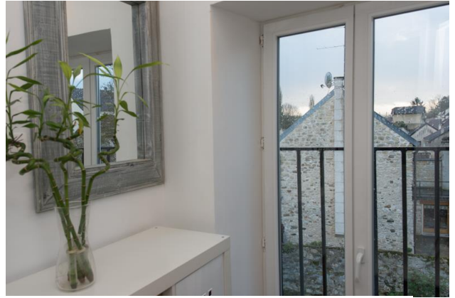
Le double vitrage a surtout permis de réduire les nuisances sonores de la route départementale qui passe près de la maison.
