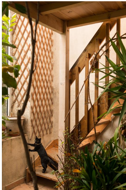
A l'origine, il faut passer par l'extérieur pour monter à l'étage. Dès son arrivée, Nicolas construit une véranda au sein de laquelle il installe un escalier.
