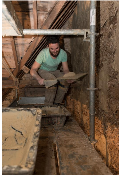
Des bénévoles, des collègues de la coopérative de bâtiment, et des amis participent au chantier de Yohann, qui durera trois jours.
