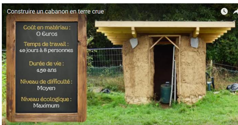
Image extraite d'un petit film pédagogique proposé par le PNR de la haute vallée de Chevreuse, et destiné à montrer comment construire un cabanon en terre crue.
