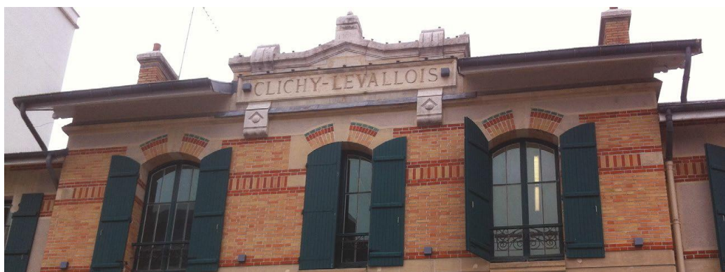
[Fig.5/ Gare de Clichy-Levallois ©Cerema]
