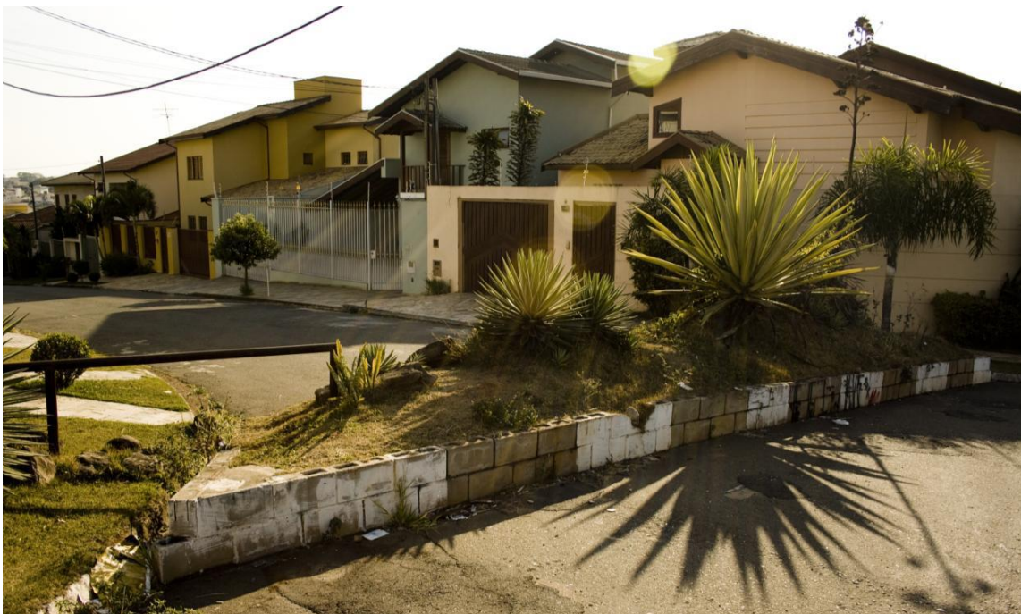
Figure 6. Bacs bloquant l'accès des véhicules à une rue du quartier Parque do Alto Taquaral, Campinas, 2010. Photo de l'auteur.
