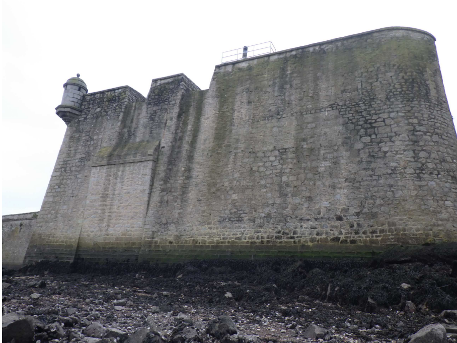
Le front Ouest et le débord de maçonnerie
