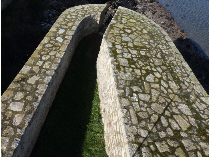
Vue de l'orillon Ouest, sur le front du bastion, le parapet a été doublé en épaisseur comme le témoigne le coup de sabre visible en plan à droite.
