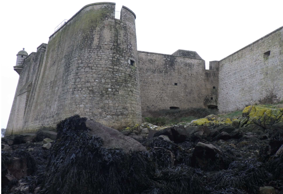
Elément du parapet 1860 conservé sur le flanc ouest du bastion.
