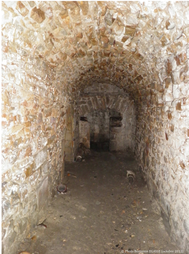
Couloir principal du bastion (photo Benjamin Egasse 2012).
