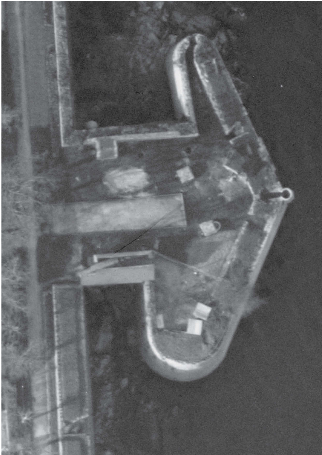
Photo aérienne du bastion de la Brèche, campagne de 1946. Les ombres portées améliorent la visibilité des éléments défensifs installés lors de l'occupation allemande de Lorient. Une plate-forme centrale occupe le centre du bastion. La guérite et le petit bâtiment sur le flanc Est sont arasés. On distingue les pivots des batteries du flanc Ouest. Les parapets sont végétalisés et les ouvertures de tirs sont encore bouchées (avant la restauration). Le parapet Ouest de la seconde moitié du XIX ème siècle paraît plus long qu'aujourd'hui (raccourci lors des restaurations). On distingue les ombres des arbres de la courtine et celle de l'arbre de l'orillon Ouest (au bas de la photo).
