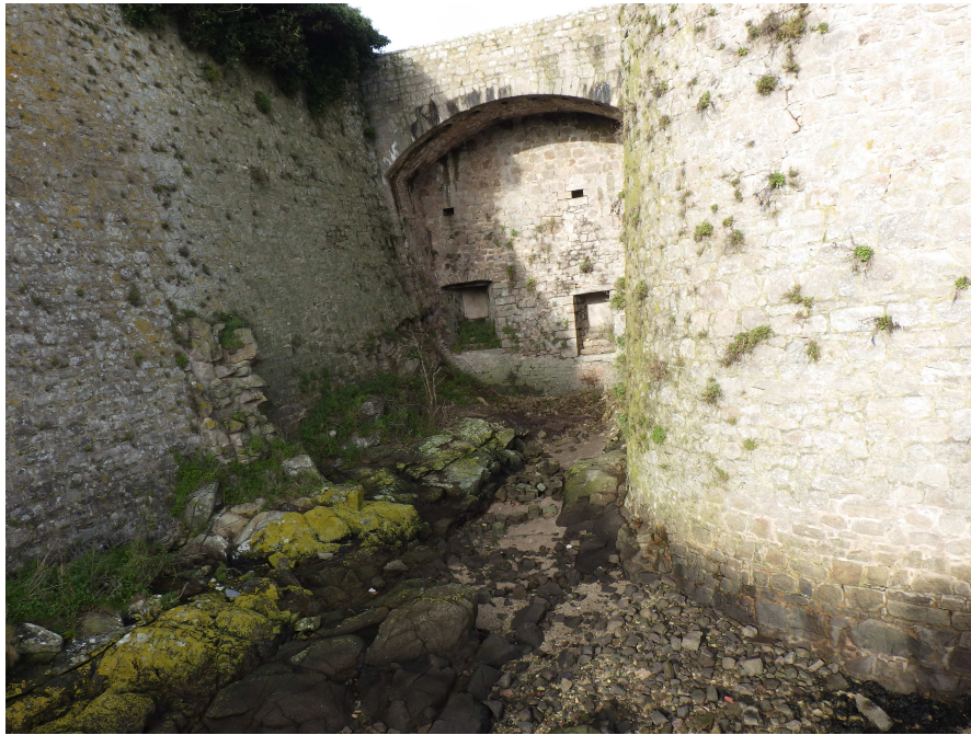
Le flanc Est du bastion de la Brèche
