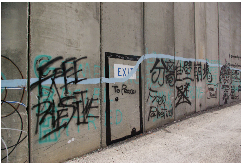
Portion du mur de séparation à Bethleem (Cisjordanie). photographie Cédric Parizot, 2009.
