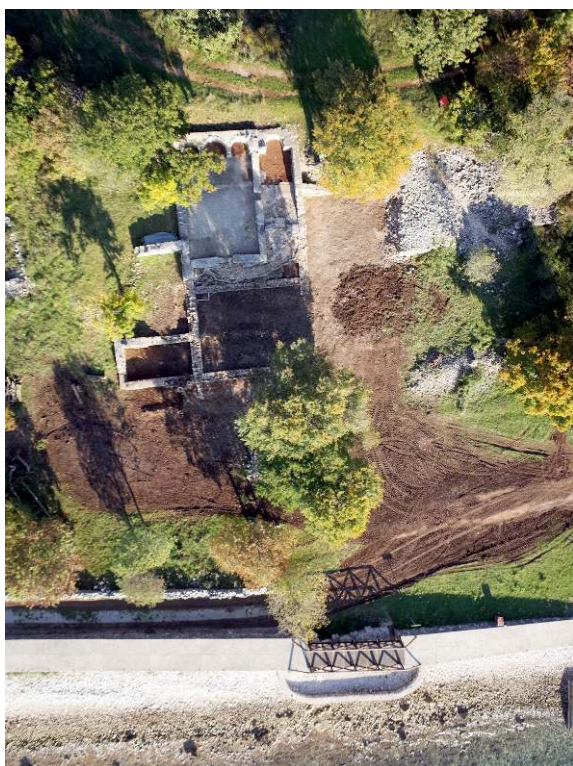
Fig. 13 – Mirine-Fulfinum, vue générale du complexe de « l'église à trois absides ».
