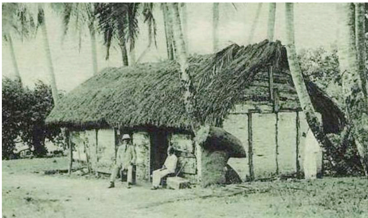
Figure 3. Case en galettes enduite de torchis, à l'Anse à l'Ane (Martinique). Source : Coll. Part.
