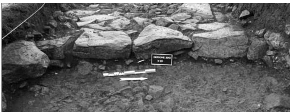
Fig. 2 : La Roche-Blanche, Gergovie, sondage 2013 : Le parement est du mur en pierre sèche.
