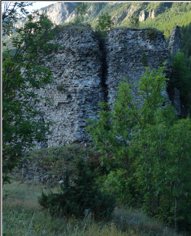
Figure 29: Maçonnerie de soutènement : face 3 (Cliché B. Oury - 2014)
