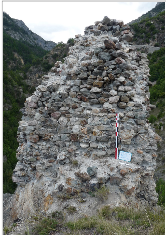
Figure 35: Relevé du mur MRb1 : parement interne (Cliché B. Oury - 2014)
