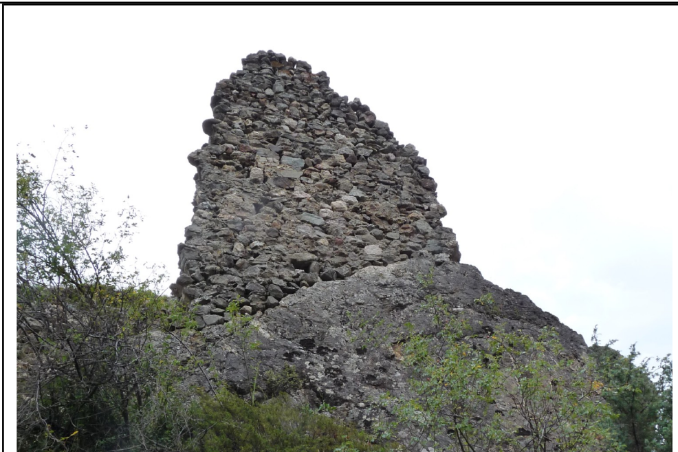
Figure 33: Mur MRb1 situé sur la plate-forme sommitale : vue depuis l'ouest (Cliché B. Oury - 2014)
