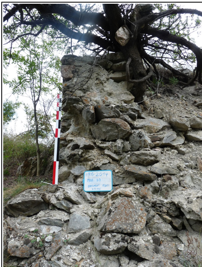
Figure 37: Relevé du profil du mur MRb2 sur la plateforme sommitale (Cliché B. Oury - 2014)
