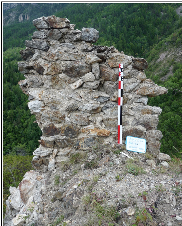
Figure 40: Relevé du mur MRb3 : parement interne (Cliché B. Oury - 2014)
