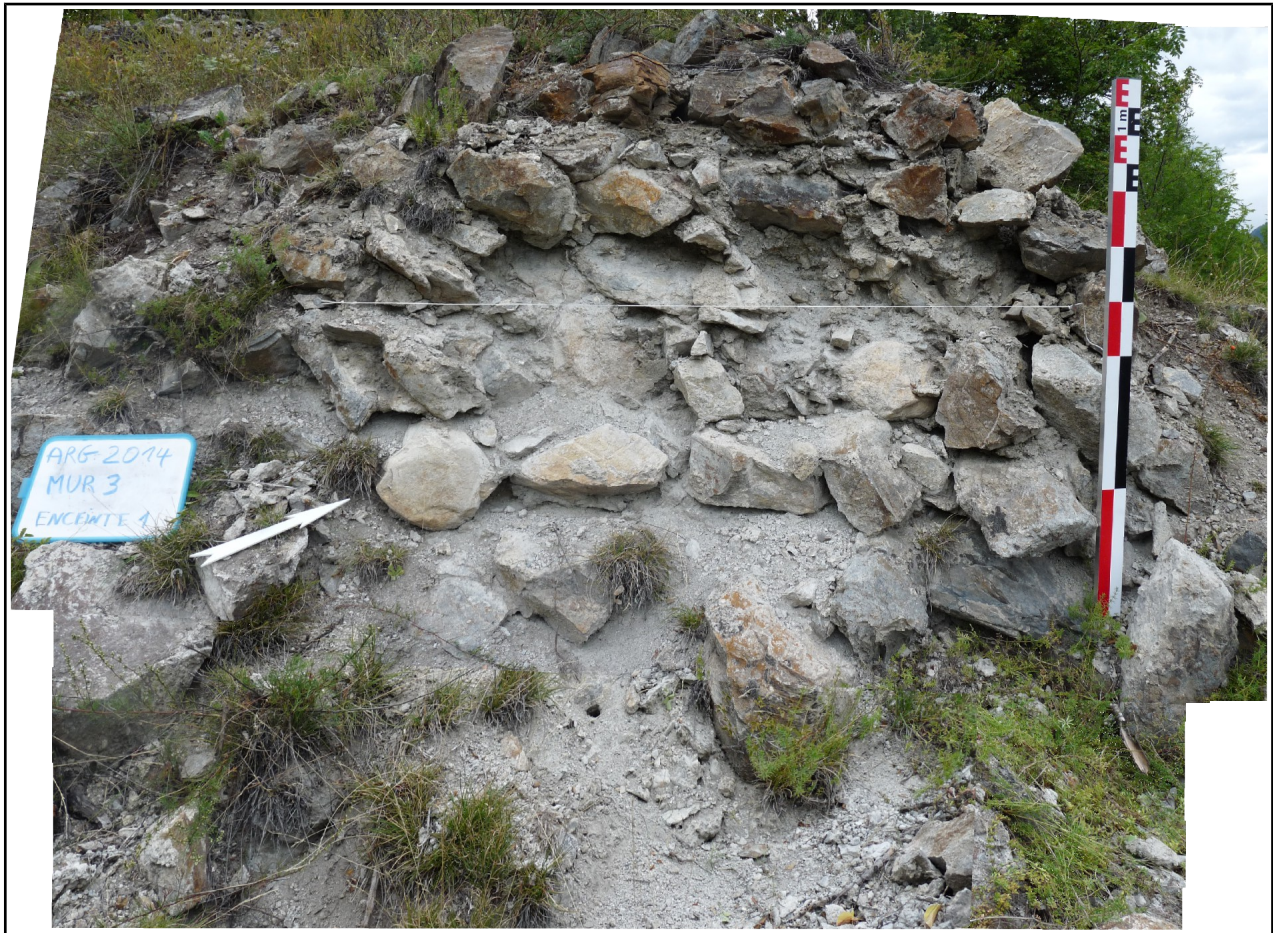
Figure 14: Relevé du mur MR3, face sud (Cliché B. Oury - 2014)
