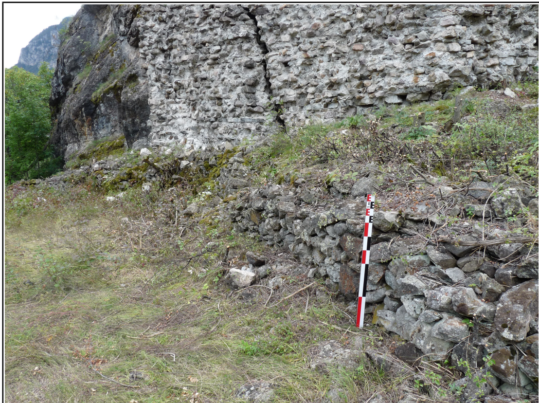
Figure 17: Mur moderne en pierres sèches élevé sur le tracé ouest du mur d'enceinte médiéval (Cliché B. Oury - 2014)
