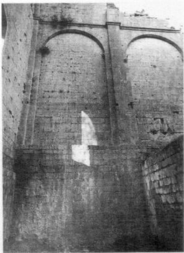
FIG. 7. — INTÉRIEUR DE LA TRAVÉE OCCIDENTALE, CÔTÉ NORD
