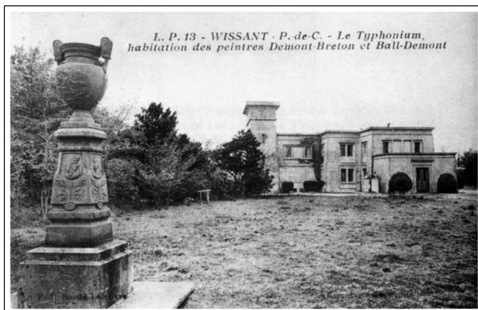
Fig. 186 : le Typhonium (construction en 1891), Wissant. (Source : http://histopale.net/les-archives/wissant/les-alentours-du-village/ )
