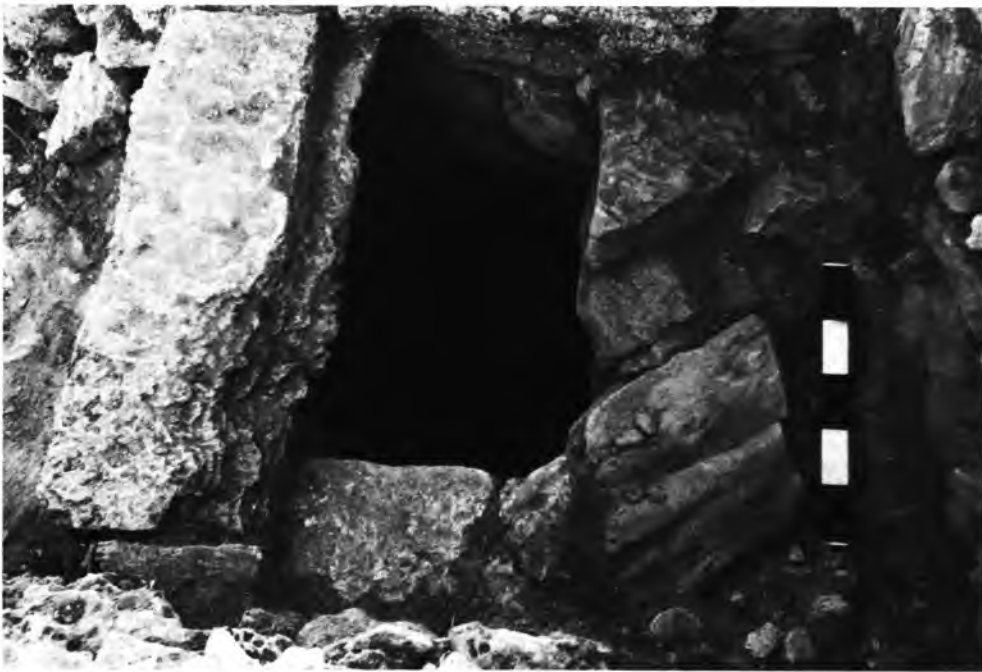
Fig. 5. Le puisard 1269, détail de l'ouverture.
