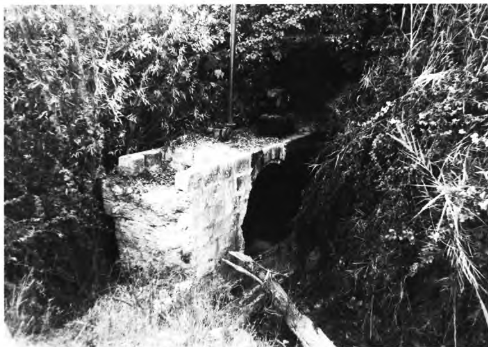
Fig. 3. Pont-barrage sur le nahr Chbayyeb.
