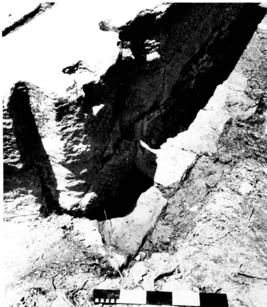
Figure 37 : Massif de la rive gauche du barrage de Ras Shamra : détail du logement des poutres et planches ; au pied du massif, marques d'érosion.
