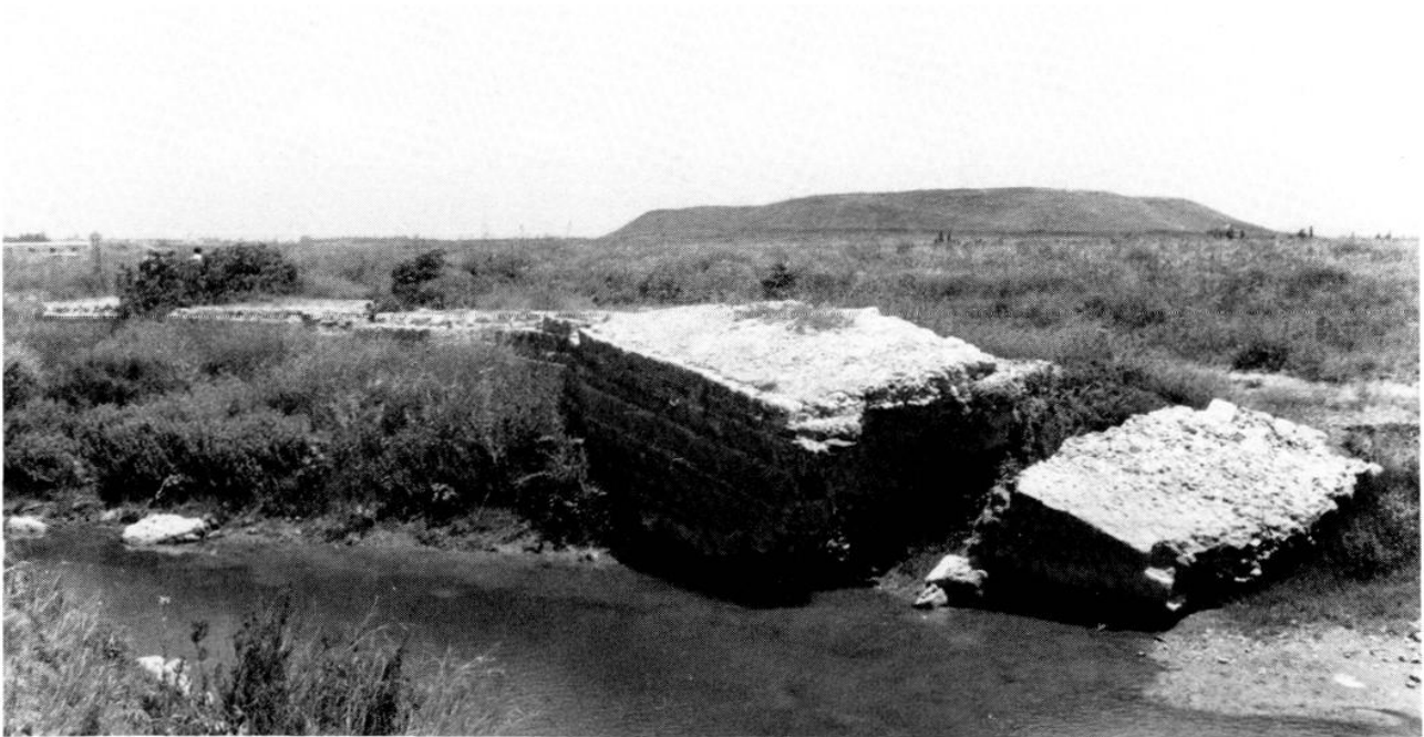
Figure 25 : Le barrage de tell Kazel, vu de la rive gauche ; au fond, le tell.
