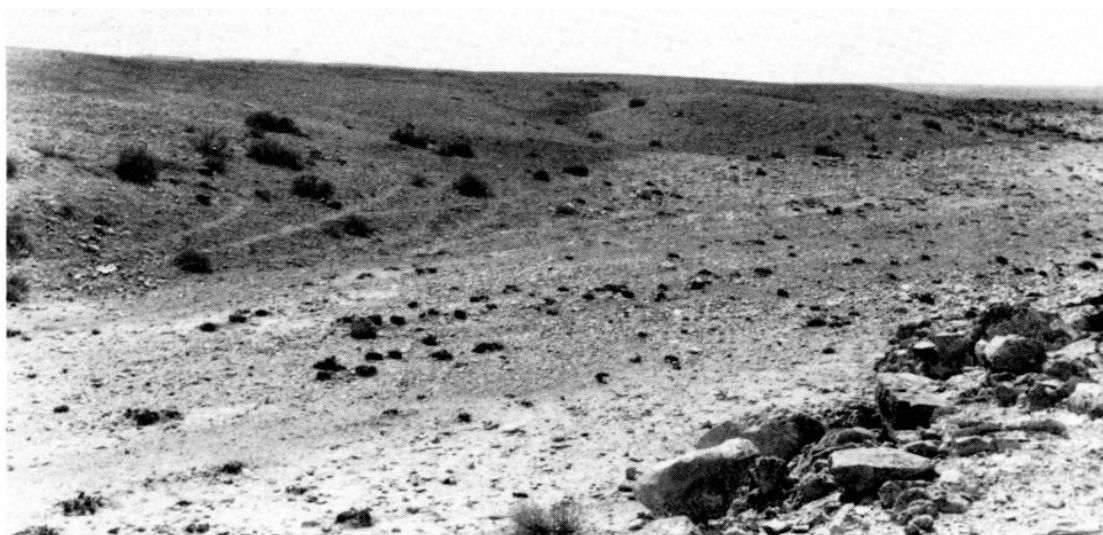
Figure 54 : Site du barrage aval de Khan al-Manqoura, vu de la rive droite ; au premier plan à droite, les vestiges du barrage ; au second plan, le lit actuel du wadi ; à l'arrière-plan au centre, le canal d'alimentation vers la dernière citerne.
