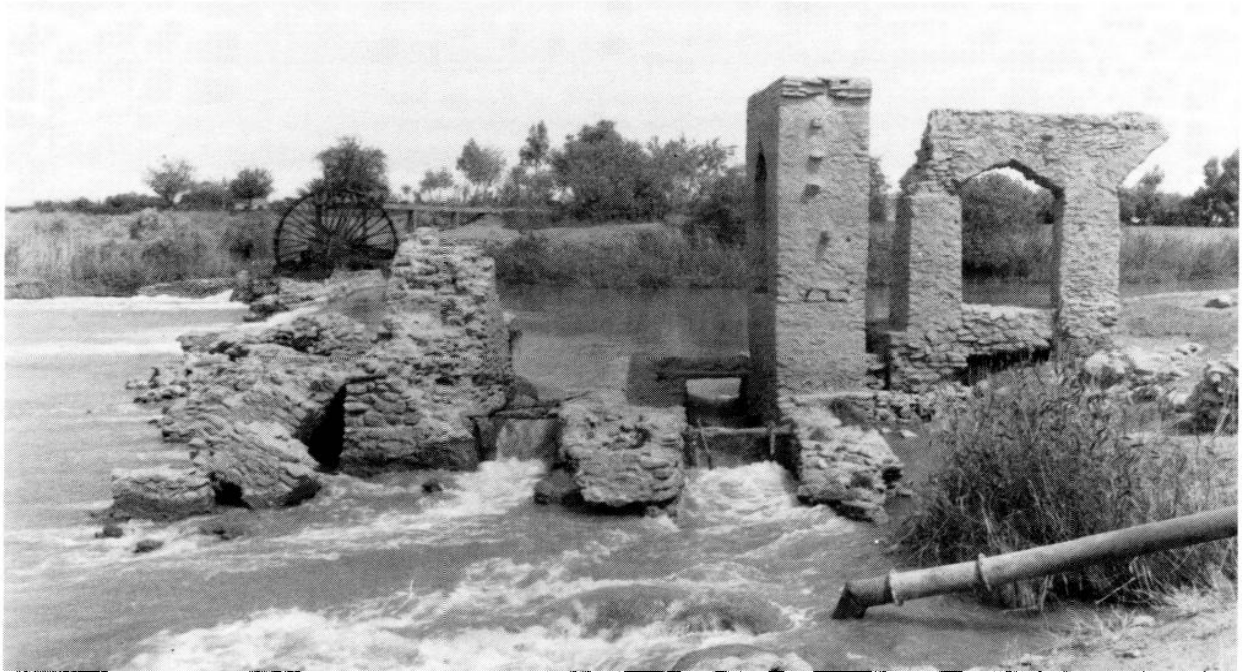
Figure 19 : Norias et barrages à Rwashed sur le Khabour, vus de la rive gauche (1987) ; au premier plan, ruines des norias photographiées par H. Charles (voir figure 20) ; à l'arrière plan, l'une des dernières norias fonctionnant encore sur le Khabour.
