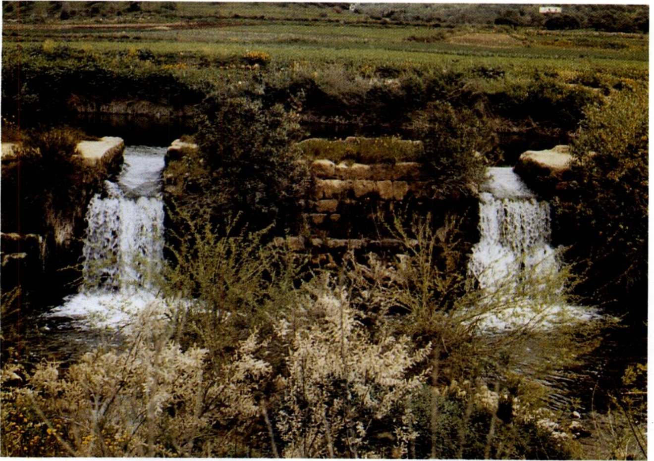
Photo VII : Le barrage de tell Safroune ; détail de deux déversoirs vus de l'aval.
