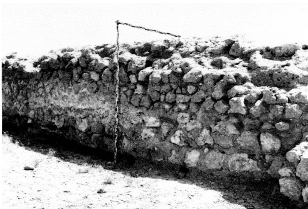
Figure 61 : Le barrage du wadi as-Souab, vu de l'amont, détail du parement.
