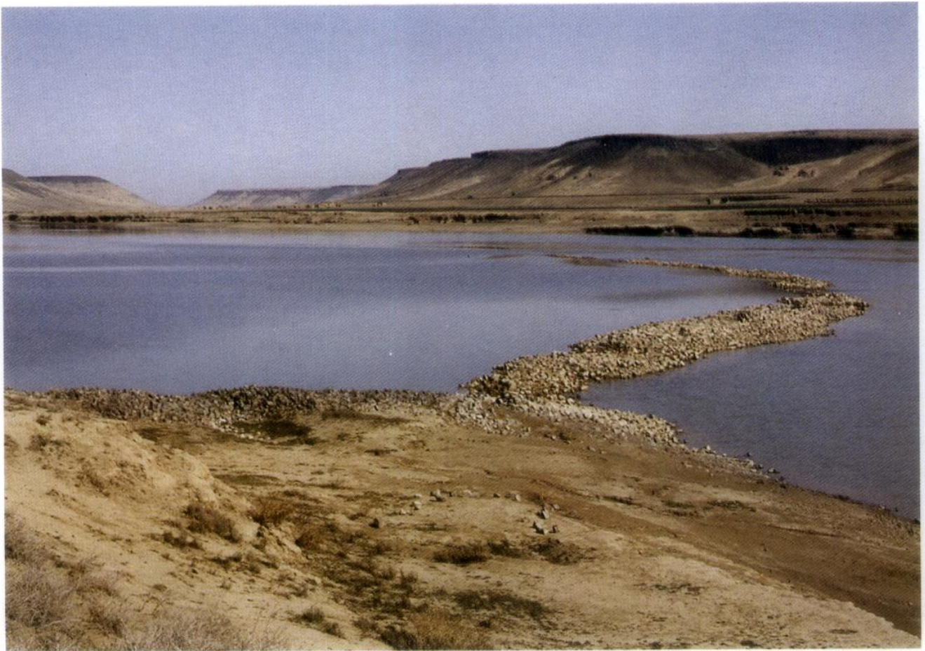
Photo I : Le barrage du Khanouqa, vu de la rive droite.
