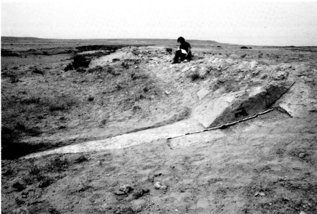
Figure 62 : Le barrage du wadi as-Souab, détail d'un déversoir.
