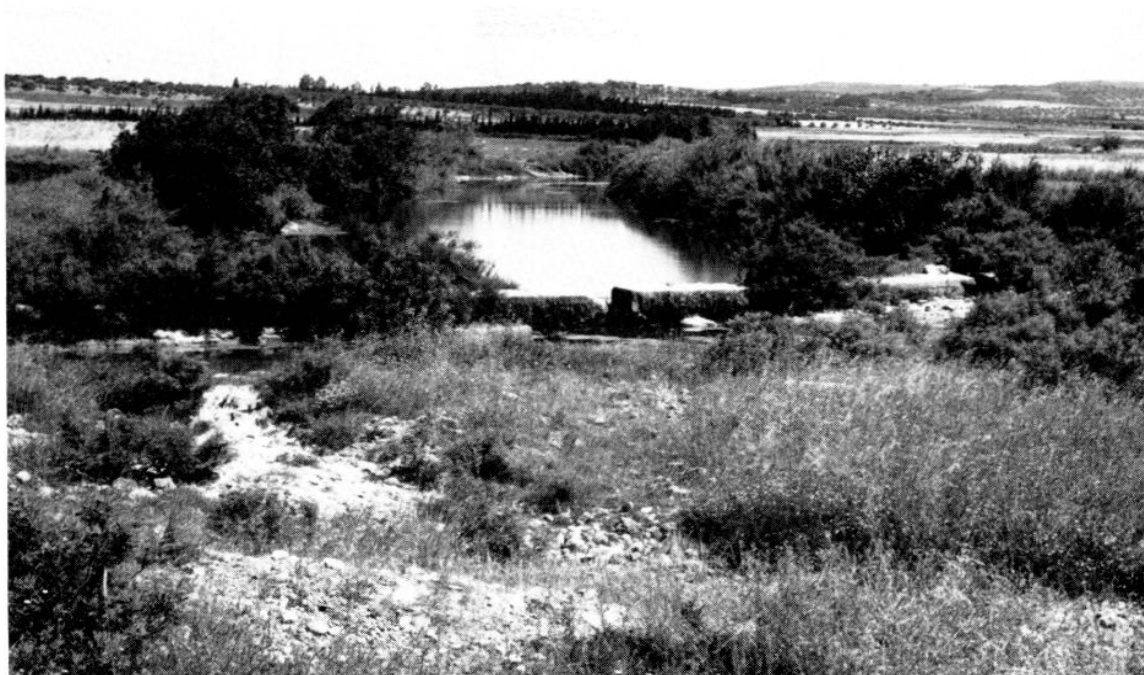
Figure 28 : Le barrage de Cheikh Mohammed, vu de l'aval.
