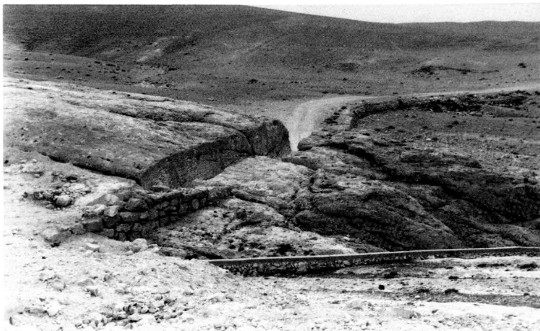
Figure 52 : Le barrage amont de Khan al-Manqoura et la saignée du canal, vus de la rive droite.
