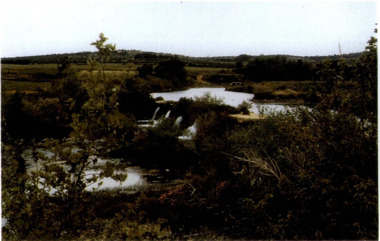
Photo VI : Le barrage de tell Safroune, vu de la rive gauche vers l'amont ; à l'arrière-plan, moulin alimenté par le barrage de Qal'at al-Araymeh.
