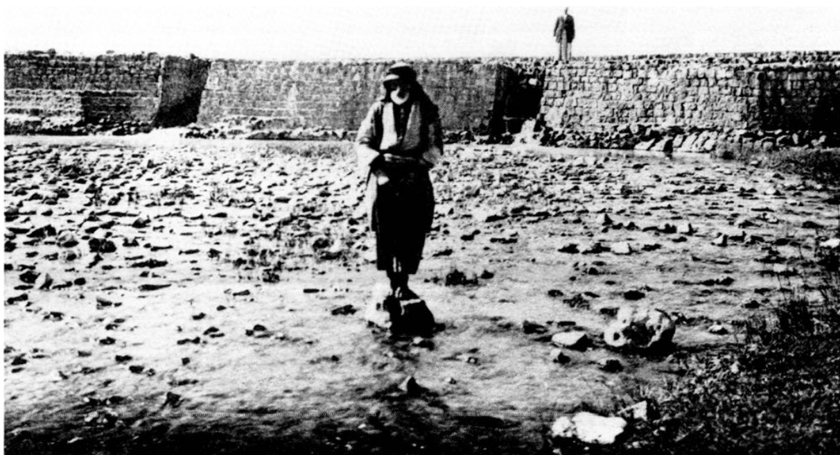
Figure 12 : Le barrage du lac de Homs, vu de l'aval (Brossé 1923, pl. XXXV 4).
