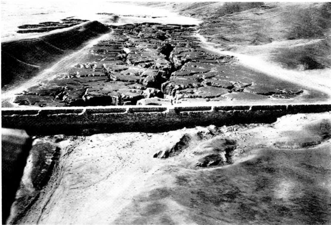
Figure 41 : Le barrage de Harbaqa vu de l'aval, vers 1930 ; à l'arrière de l'ouvrage, l'ancienne retenue, comblée par des sédiments réincisés (photo de Boysson, Poidebard 1934, pl. XXXIII).
