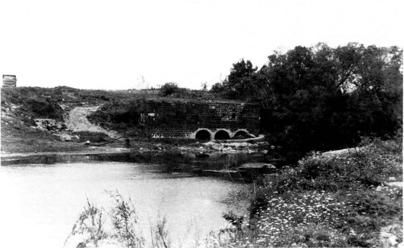
Figure 33 : Le moulin de Tahoun al-Jadid, alimenté par le barrage de Qal'at al-Araymeh.
