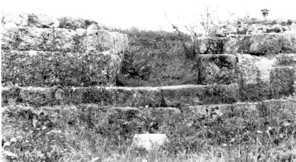
Figure 27 : Le barrage de tell Kazel ; détail d'un déversoir, vu de l'aval.
