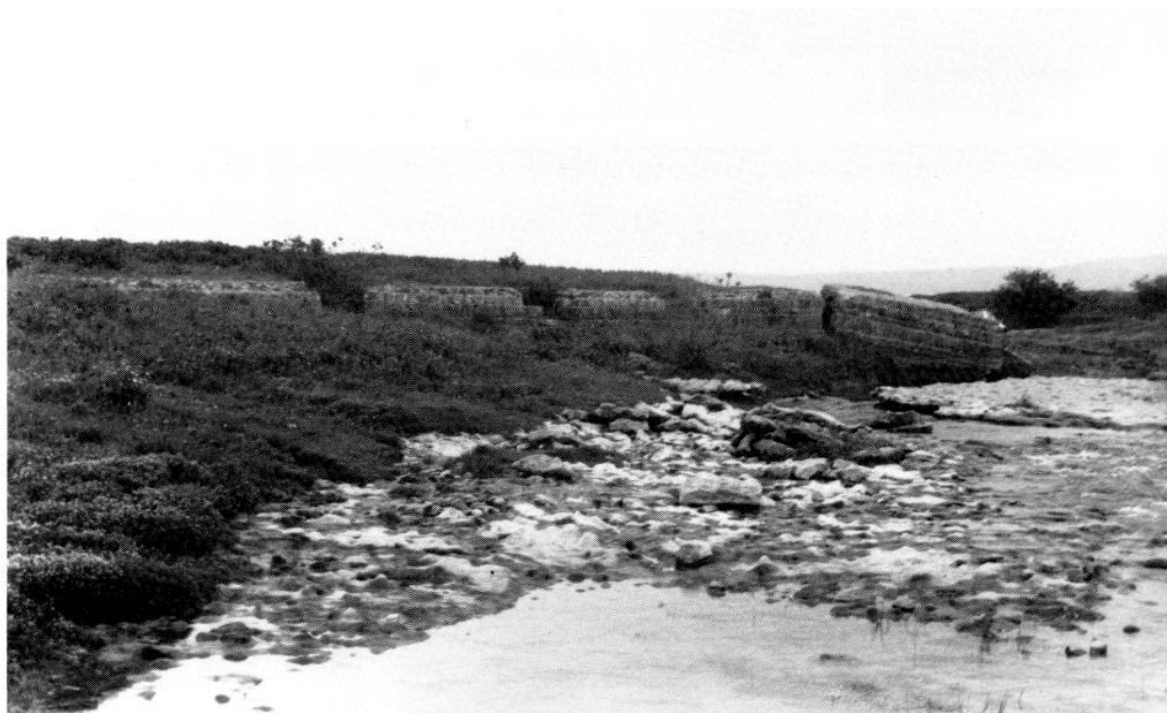
Figure 26 : Le barrage de tell Kazel avec ses déversoirs, vu de l'aval.
