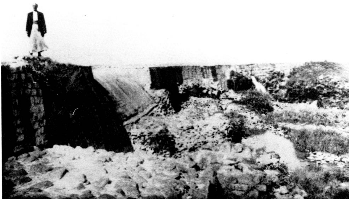
Figure 13 : Le grand déversoir du barrage du lac de Homs (Brossé 1923, pl. XXXVII 2).
