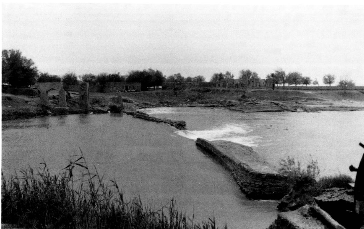
Figure 23 : Barrage de Rweshed vu de l'amont ; au premier plan, le départ du canal de la noria.
