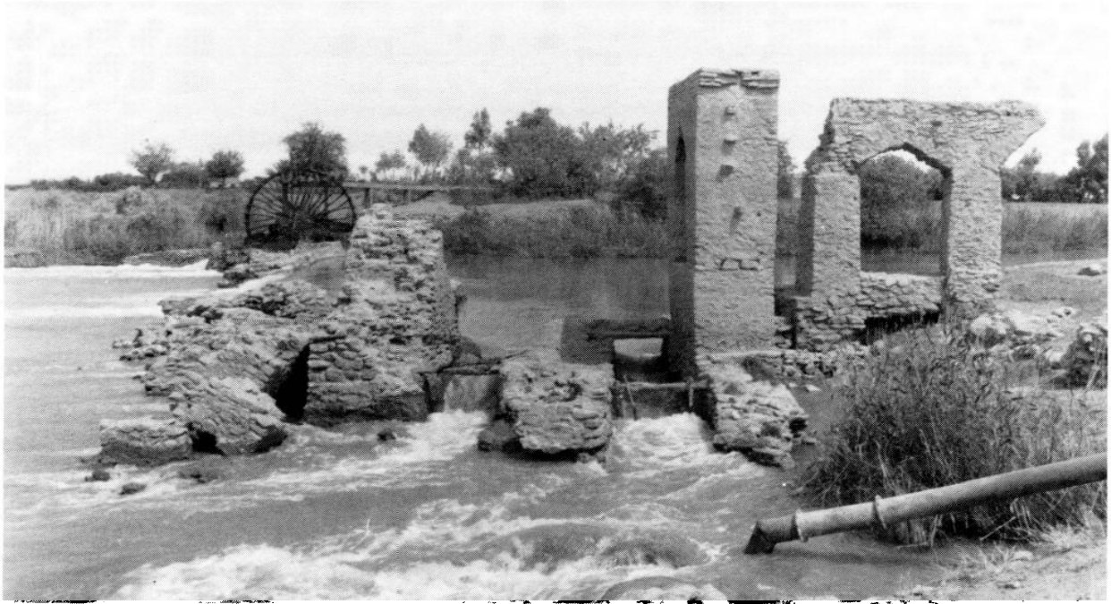
Figure 19 : Norias et barrages à Rwashed sur le Khabour, vus de la rive gauche (1987) ; au premier plan, ruines des norias photographiées par H. Charles (voir figure 20) ; à l'arrière plan, l'une des dernières norias fonctionnant encore sur le Khabour.
