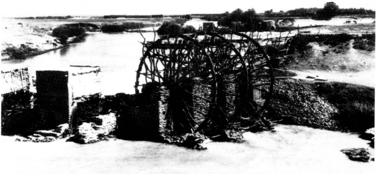
Figure 20 : Les aménagements de Rwashed, dans les années trente (Charles 1936, pl. XVI, entre les p. 144-145).
