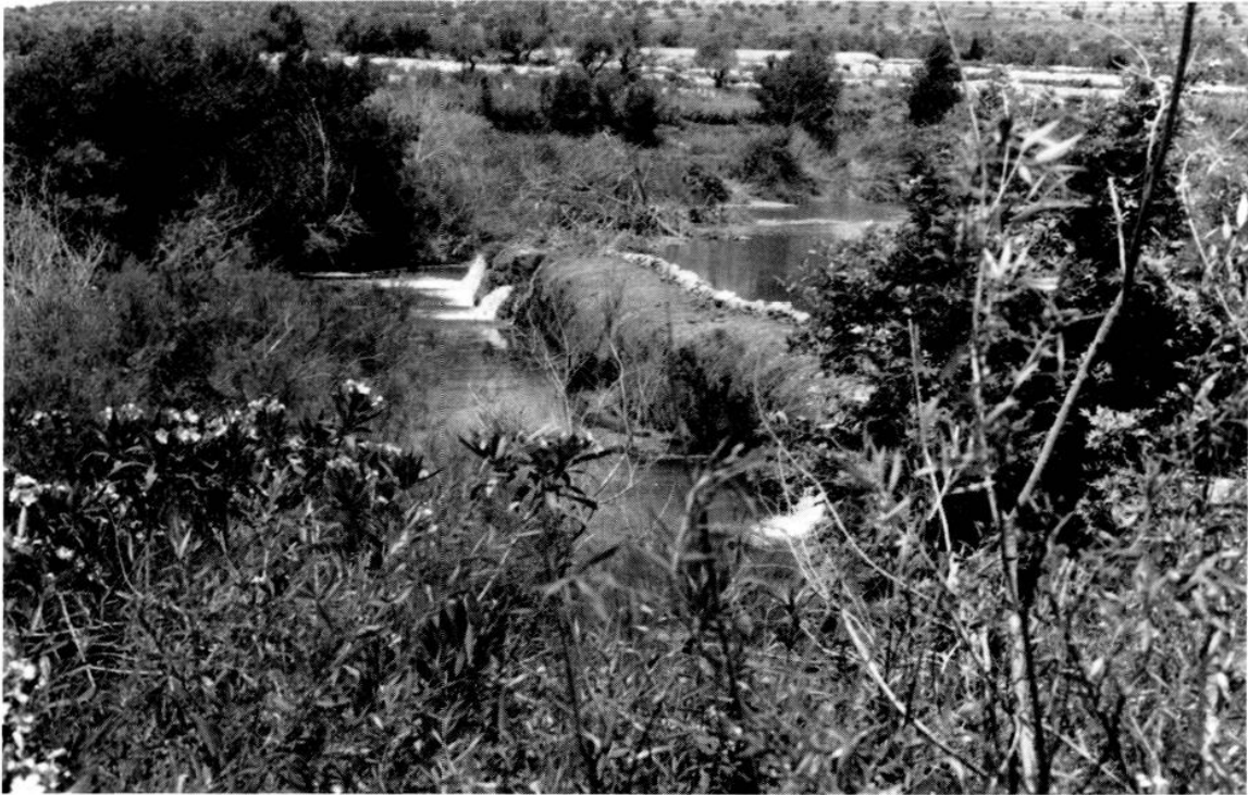
Figure 31 : Le barrage d'ar-Rouess, vu d'aval, de la rive gauche.
