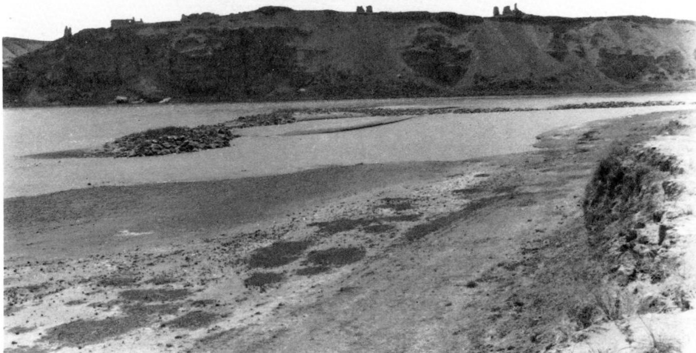
Figure 6 : Vestiges d'un probable perré de protection du canal sous le site de Zalabiya.
