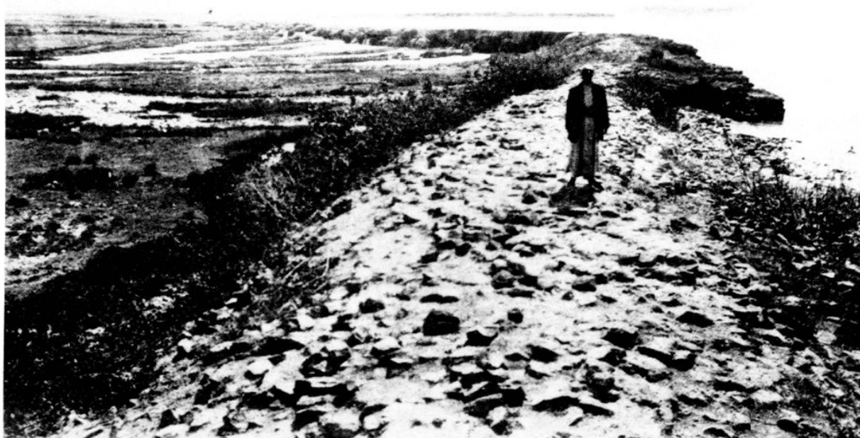
Figure 11 : Le barrage du lac de Homs, vers le sud-est (Brossé 1923, pl. XXXV 3).
