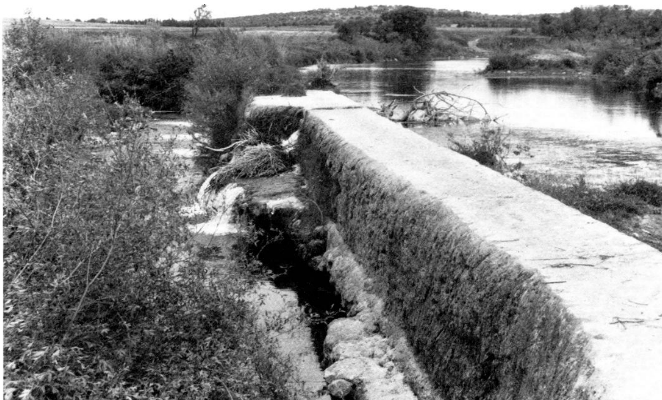
Figure 29 : Le barrage de tell Safroune ; détail de la digue récente.
