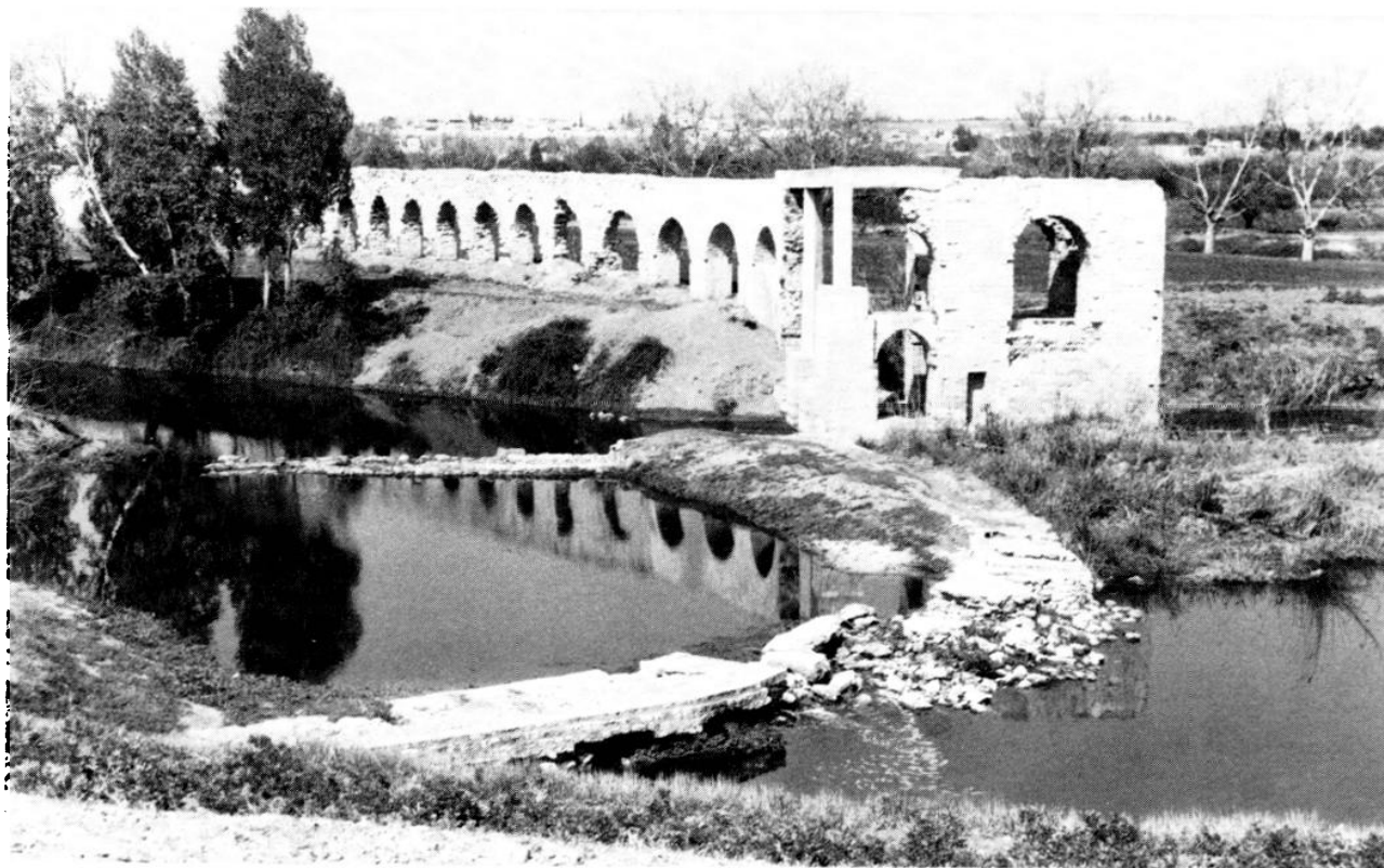
Figure 16 : Barrage de noria sur l'Oronte en aval du hameau de Jrabiyat, en face de Khattab (1990) ; cette noria irriguait le Zor al-Jadid.
