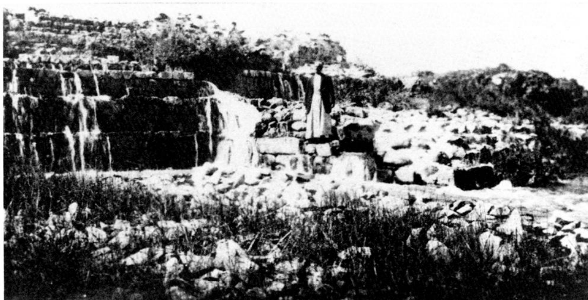
Figure 14 : Partie centrale du barrage du lac de Homs, vue de l'aval ; infiltrations à travers la paroi (Brossé 1923, pl. XXXVI 2).
