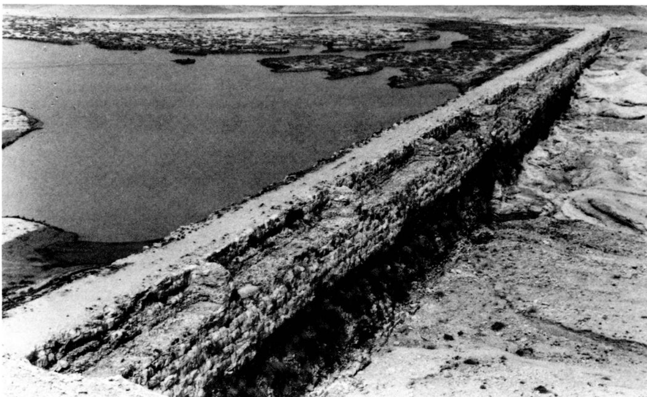
Figure 43 : État actuel du barrage de Harbaqa (1990).
