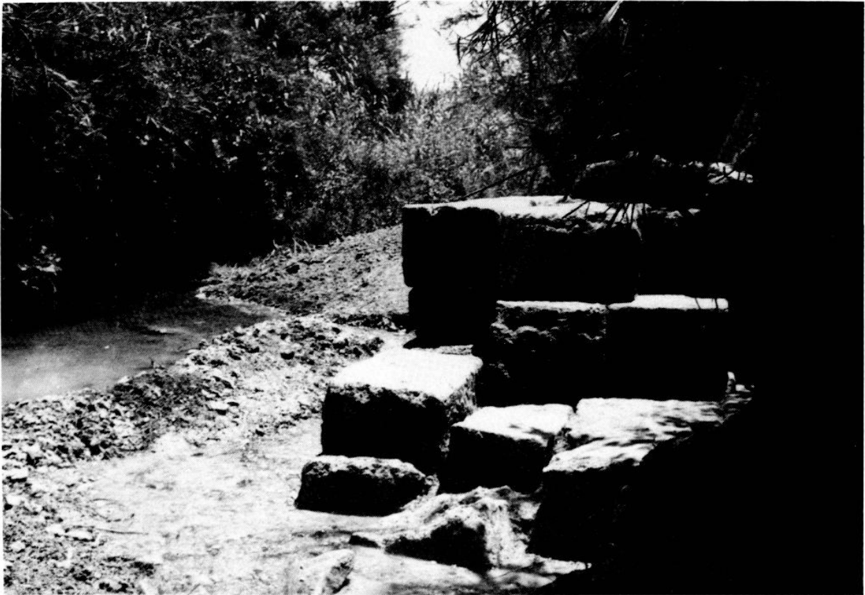
Figure 38 : Le massif de la rive gauche du barrage de Ras Shamra, vu de l'aval.
