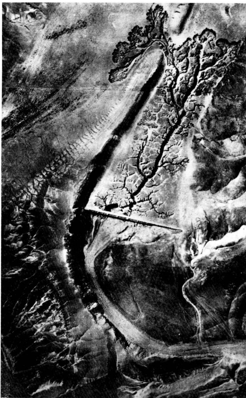
Figure 42 : Vue aérienne du barrage de Harbaqa et de ses environs, vers 1930 (photo de Boysson, Poidebard 1934, pl. XXXIV).
