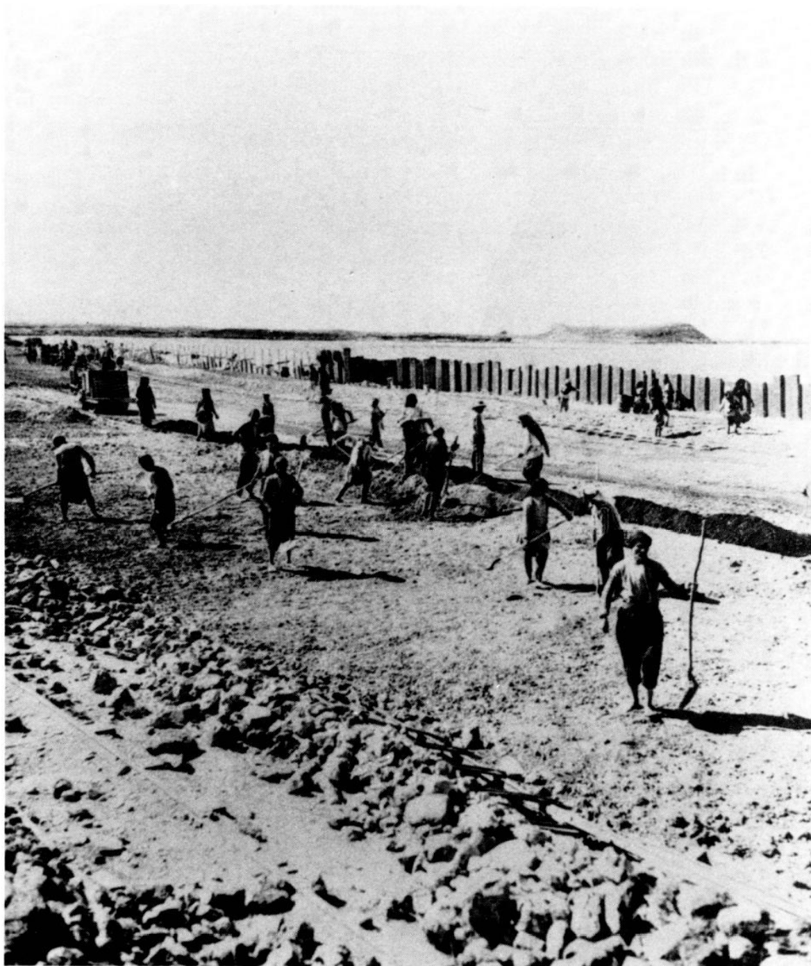
Figure 9 : Réaménagement du barrage du lac de Homs ; au fond, le tell de Qattiné (Weulersse 1940 a, pl. II 3).
