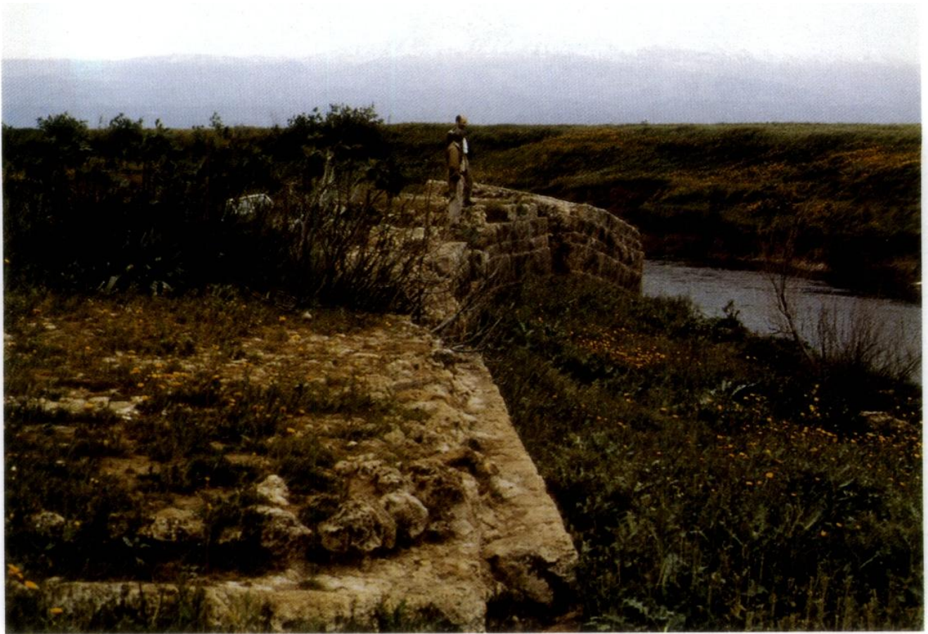
Photo V : Le barrage de tell Kazel (face aval).
