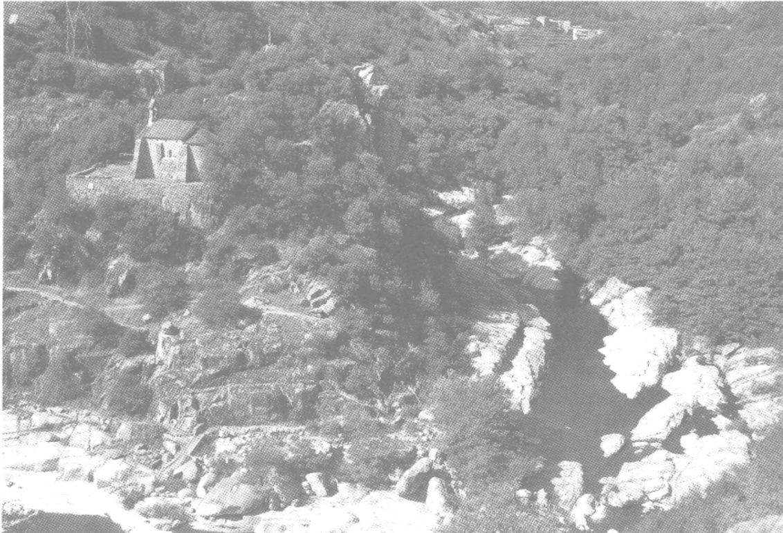
Figure 3. — Château et chapelle castrale de Pied-de-Borne (Lozère) Cet ensemble fait partie du dispositif de surveillance du territoire minier de la vallée du Chassezac (cliché M.-Chr. Bailly-Maître).
