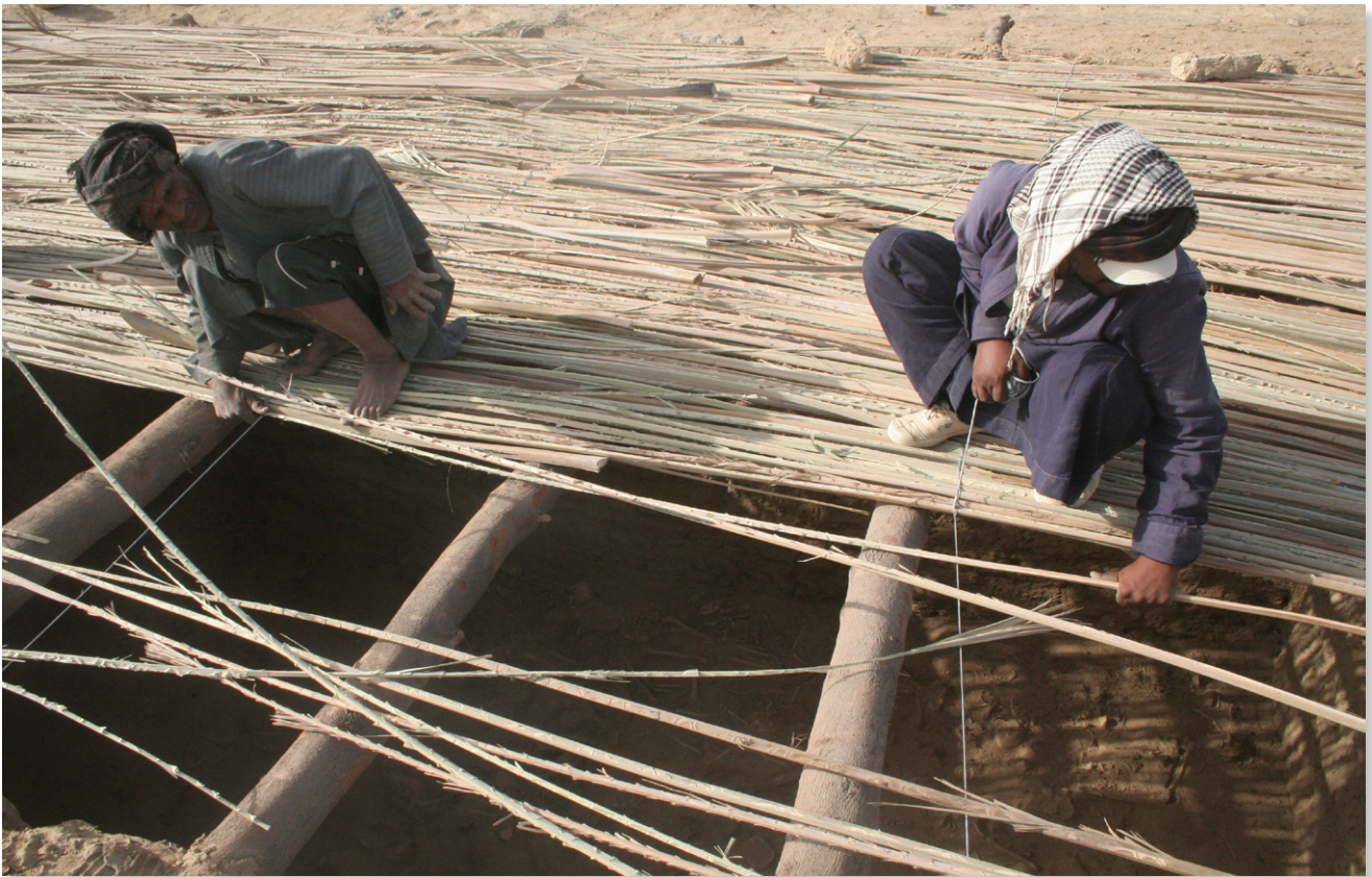
Figure 7 A-B : Expérimentation de couverture non hermétique en matériaux légers, construite au-dessus du caisson 413. Cliché Fr. Colin, 2010.
