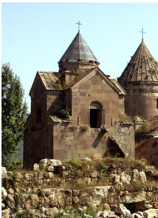
Fig. 11. Gochavank : Bibliothèque-chapelle-campanile (1291). Photo P. Donabédian.
