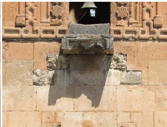
Fig. 8. Éghvard. Ste-Mère de Dieu. Porte du niveau intermédiaire. Seuil saillant et début d'escalier suspendu. Photo P. Donabédian.
