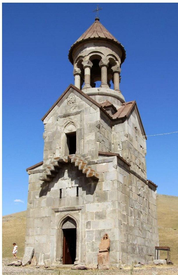
Fig. 14. Kapoutan. Chapelle-mausolée Saint-Ménas de Kaptavank' (1349). Photo P. Donabédian.
