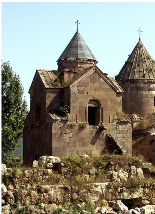
Fig. 11. Gochavank : Bibliothèque-chapelle-campanile (1291). Photo P. Donabédian.
