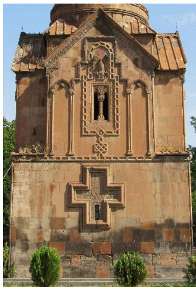
Fig. 18. Éghvard. Ste-Mère de Dieu. Façade sud. Photo P. Donabédian.
