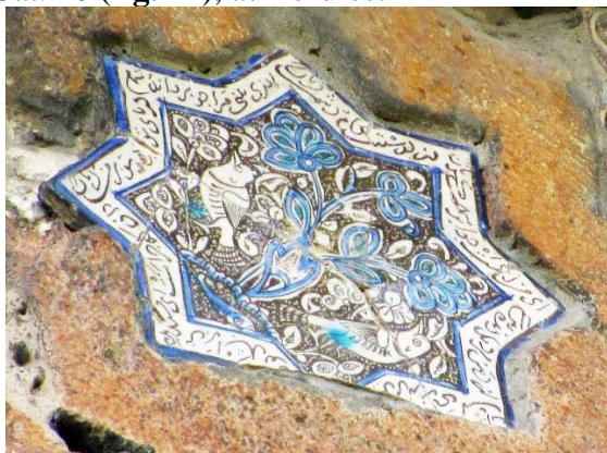
Fig. 44. Éghvard. Carreau Cat. 10, sur la face nord-est de la rotonde. Photo P. Donabédian.
