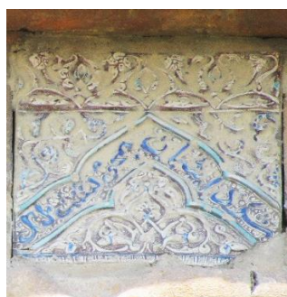
Fig. 37. Éghvard. Ste-M. de D. Carreau Cat. 51, face SE de la rotonde. Photo P. Donabédian.
