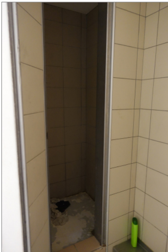
IMAGE 8. DOUCHE DANS UNE CELLULE EN ETABLISSEMENT PUBLIC POUR MINEURS
