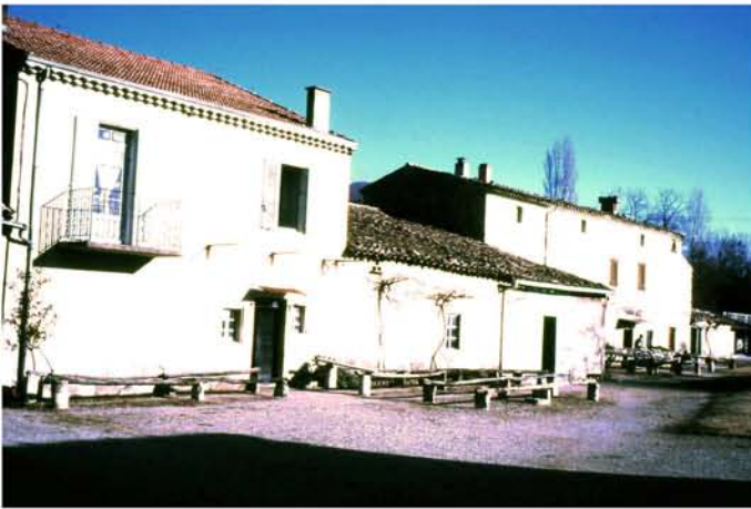
Figure 13 : Séchoir extérieur de l'atelier de la Grande Cheminée. Cliché F. Isler.
