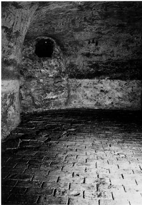
Figure 7 : Dieulefit : fosse à décantation de l'argile de l'atelier Flotte (cliché F.M.)
