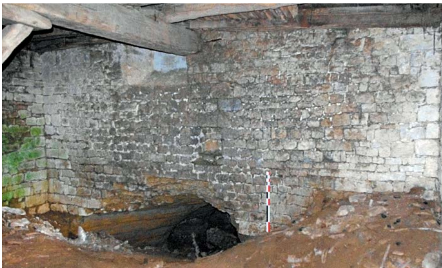
Fig. 8 - Accès à la cave N par une ouverture pratiquée à la base du mur pignon sud.
