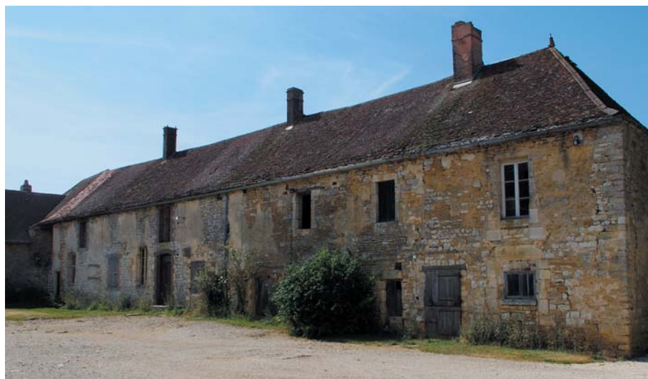
Fig. 5 - Façade orientale vue depuis le nord. Cliché C. Roms, INRAP.
