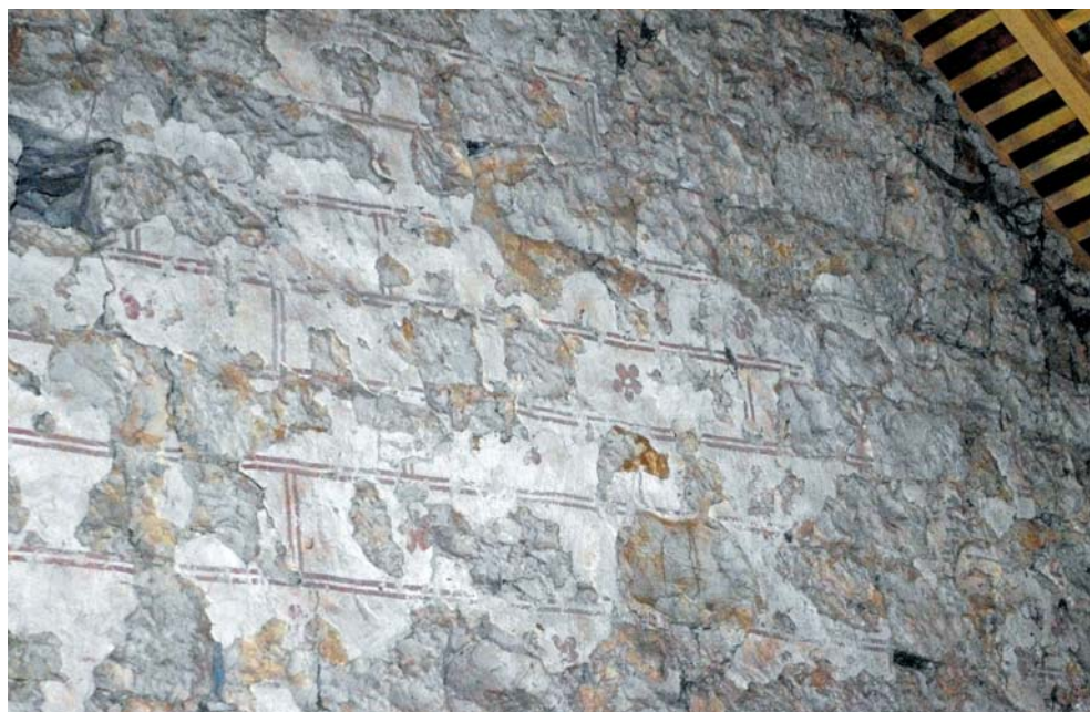
Fig. 9 - Détail de l'enduit peint du mur pignon sud. Cliché C. Roms, INRAP.
