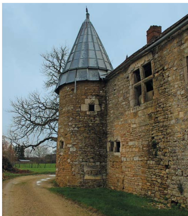
Fig. 6 - Tour de la façade occidentale. Cliché C. Roms, INRAP.
