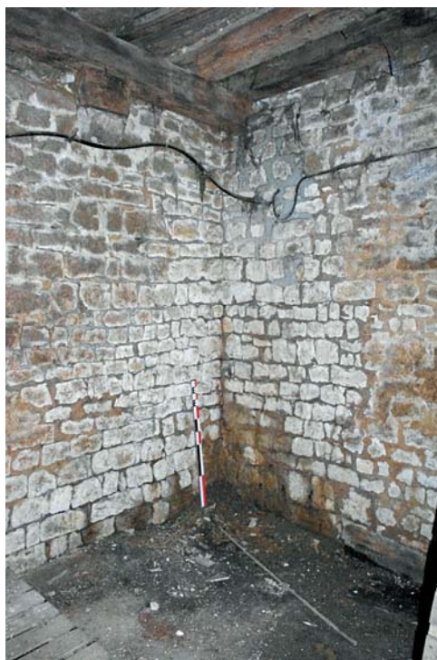
Fig. 7 - Détail de l'appareil de la cave B (angle du mur de refend 8 et du mur gouttereau est). Cliché C. Roms, INRAP.
