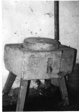
Fig. 18: Moulin à vernis en auge à barre excentrique en Hongrie, à la frontière de la Slovénie, XXe s. Cliché D. Foy.
