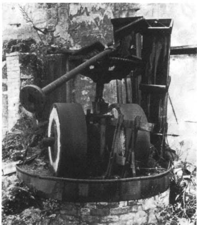
Fig. 46: Moulin à manège pour la terre, Briqueterie Ducros à Saint-Quentin-La-Poterie. Cliché F. Isler.
