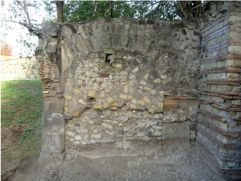
Fig. 8 – Bouchage de l'arche ouest du portique vue depuis l'est.
