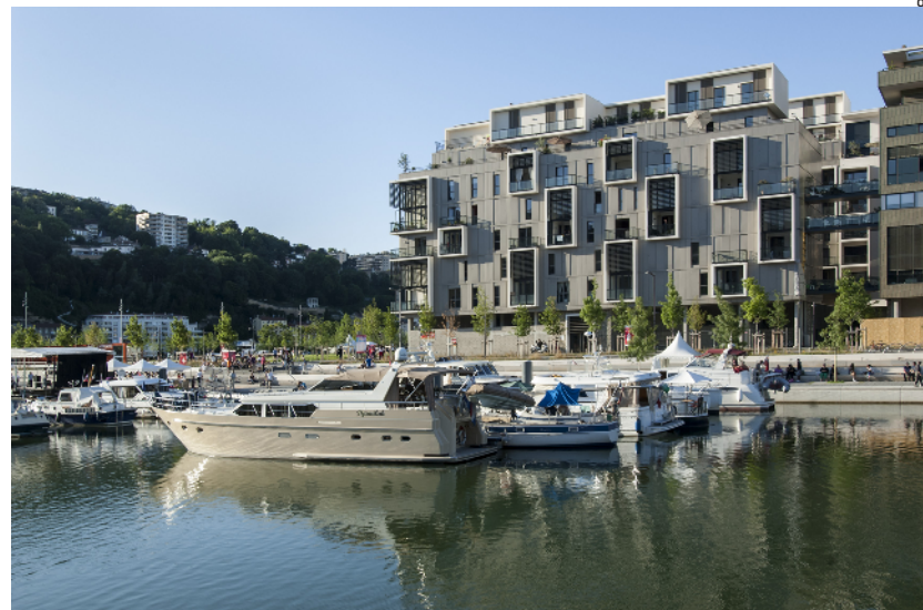
Vue des loges depuis la darse. Concepteur(s) : Dusapin - Leclercq (photographie réalisée dans le cadre de la mission architectures nouvelles et patrimoine bâti 2011-2012) © Aurélie Leplatre, et SPLA Lyon Confluence.
