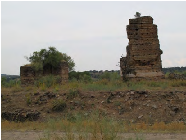
Fig. 12. Cara sur de las torres T1 y T2 que pertenecen a un dispositivo de entrada(© Proyecto Albalat, 2011)
