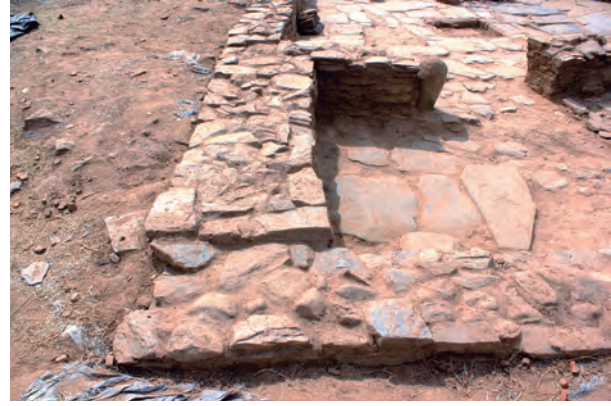
Fig. 21. El relleno interior del muro se deja más elevado que las piedras que lo carean por el exterior para evitar acumulaciones de agua y facilitar el desagüe, impidiendo con ello infiltraciones en el muro, que podrían debilitarlo
