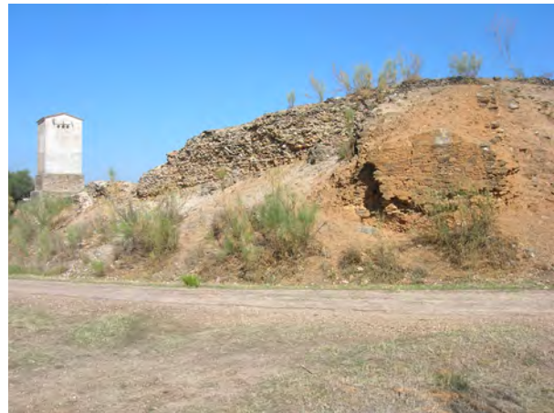
Fig. 13. Tramo elevado del frente suroeste con la torre T4 en ángulo saliente (© Proyecto Albalat, 2011)
