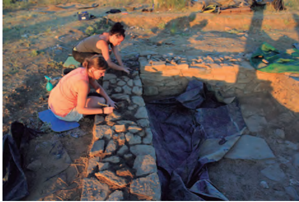
Fig. 20. Proceso de espatulado de los morteros para evitar la aparición de grietas que puedan favorecer la infiltración de agua de lluvia
