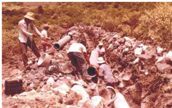
**Imagen 1 - CF-1103-33798 – Trabajadores colocando la tubería en la línea de conducción del manantial Chihuahuita a Xoxocotla, agosto de 1975, municipio de Tlaltzapán, Morelos.**
