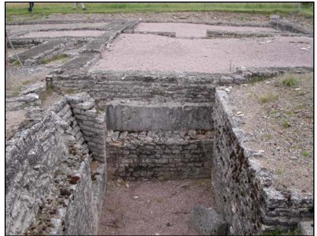
23B LA NICHE, MUR NORD
