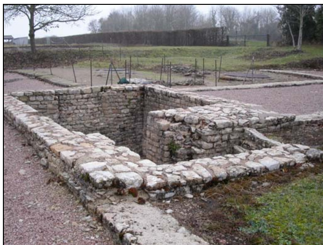
18A VUE PRISE DU NORD-OUEST
